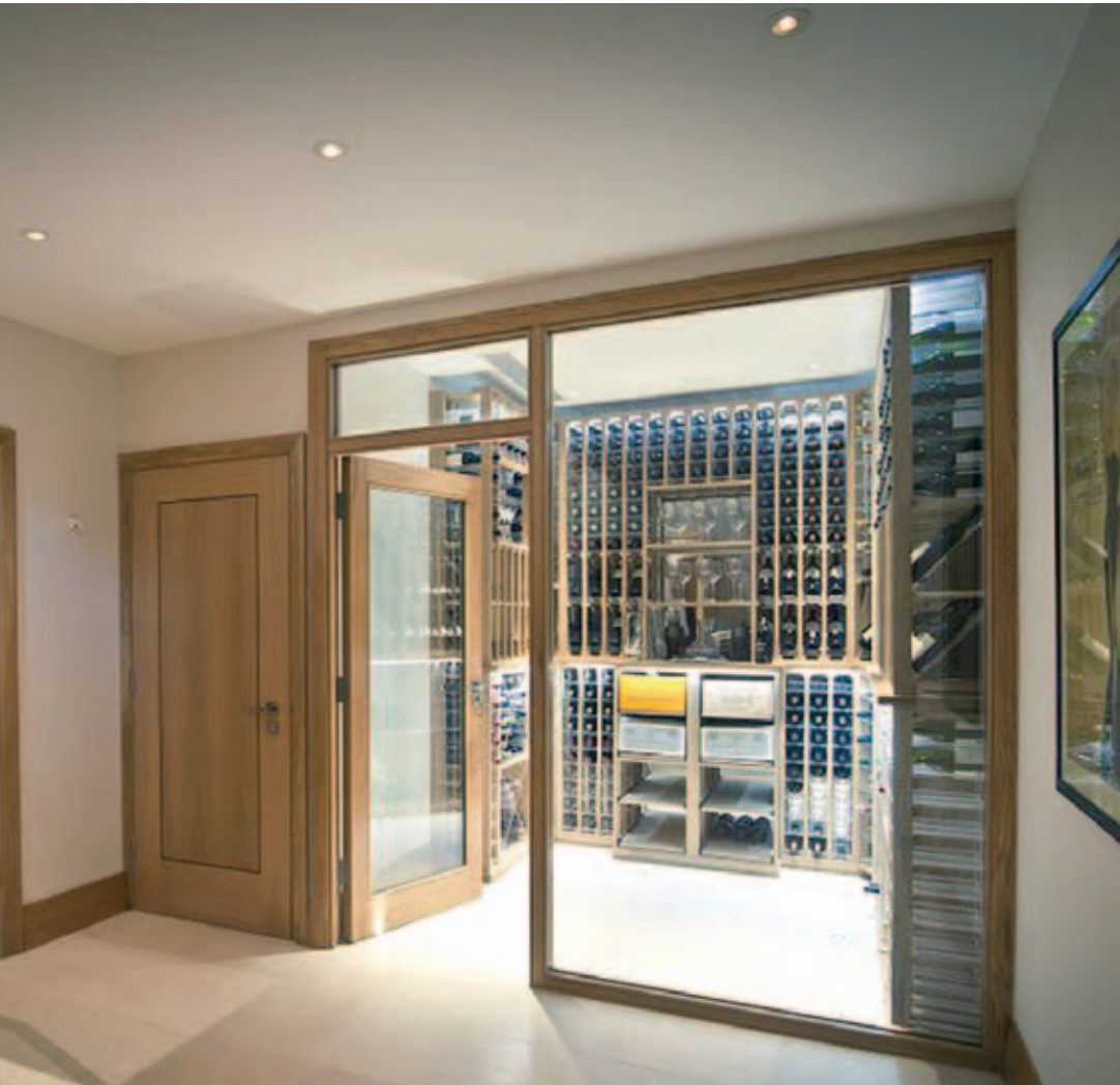
Komplett-Umbau zum klimatisierten Weinkeller mit Isolierglaswand.
